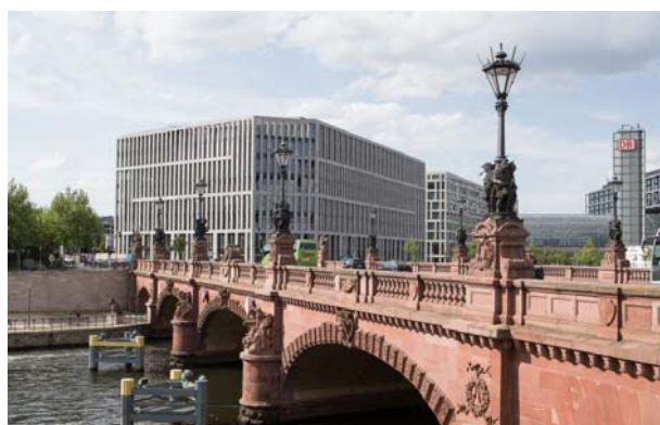
2015 fertig gestellt und in den Bestand übernommen: Das John F.-Kennedy-Haus am Berliner Hauptbahnhof
