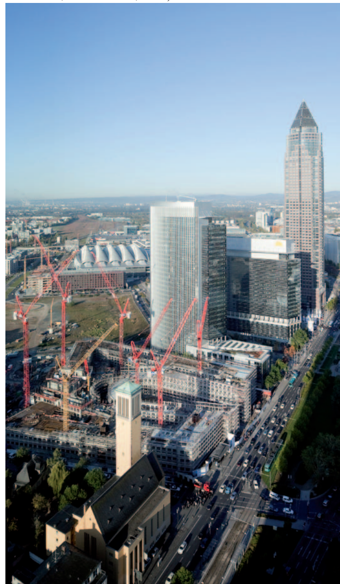
TOWER 185 Frankfurt, Baustellenansicht, Stand: Jänner 2010
