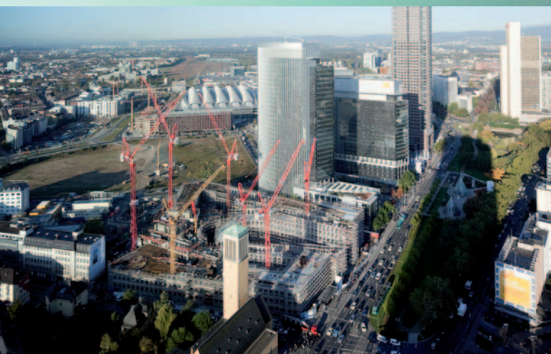
BAUSTELLENANSICHT TOWER 185 STADTQUARTIER EUROPASVIERTEL, FRANKFURT Vorertifizierung für nachhaltiges Bauen, Fertigstellung Ende 2011
