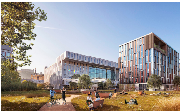
Das in Fertigstellung befindliche Gebäude Missouri Park ist eines der beiden letzten Bausteine der Quartiersentwicklung „River City Prague“.
