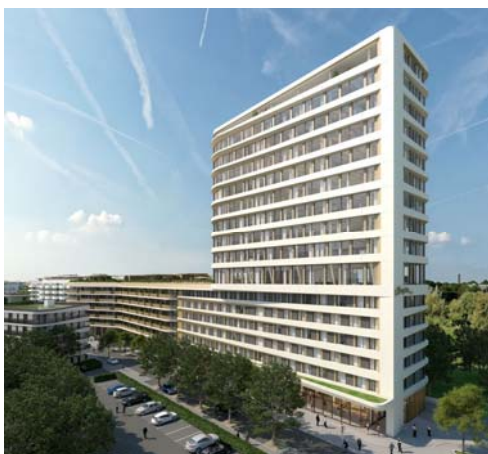
In München entwickelt CA Immo den Gebäudekomplex NEO
