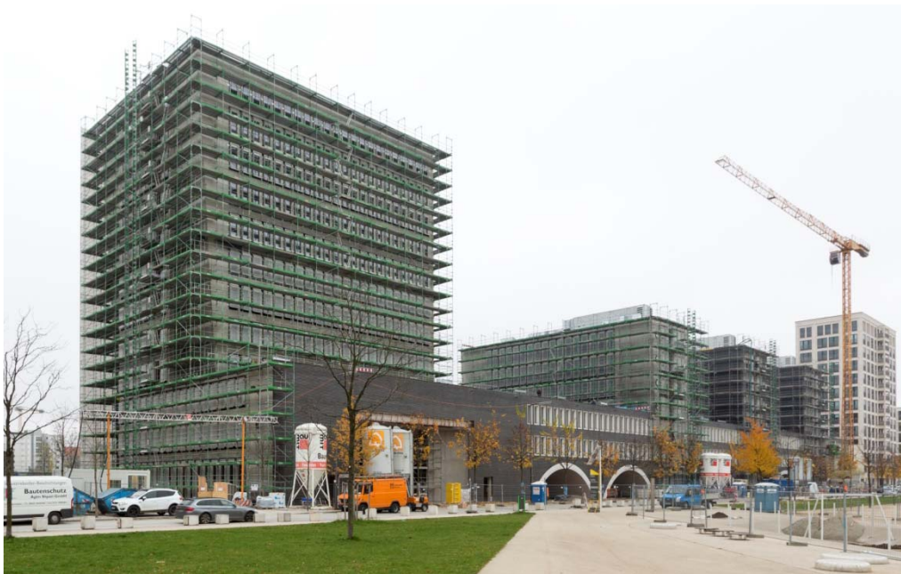
Baustelle des Bürogebäudes Kontorhaus in München
