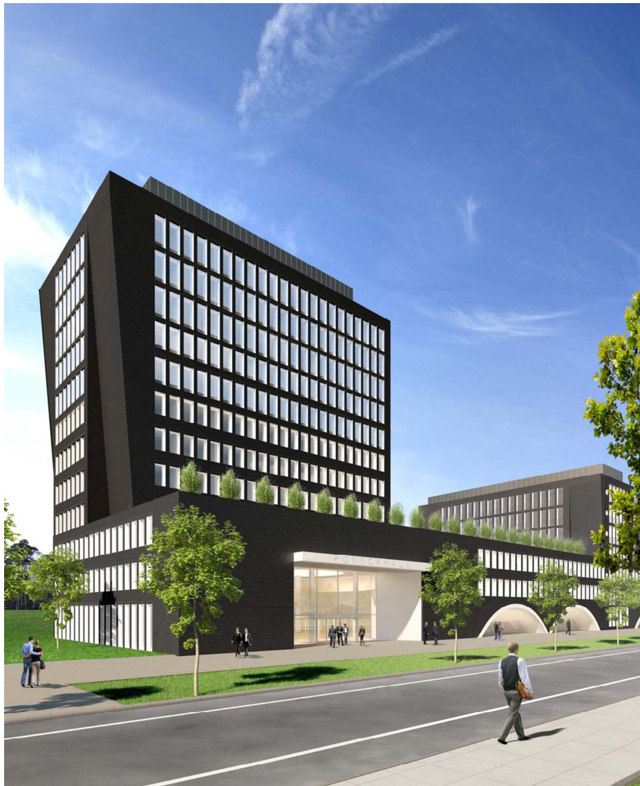
Visualisierung des Bürogebäudes KONTORHAUS im Arnulfpark München
