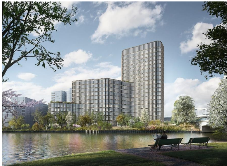
Upbeat (im Bau)
