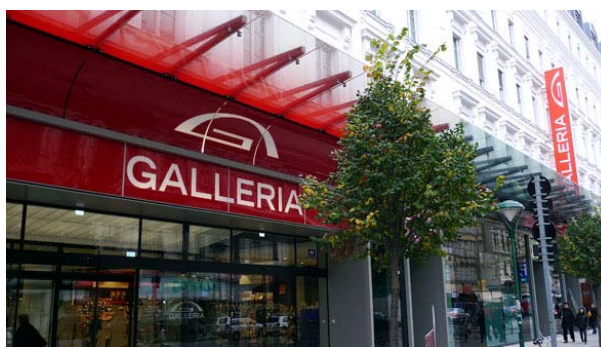
WIEN, Einkaufszentrum Galleria
