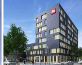
FRANKFURT/MAIN Europaviertel, Nord 4 Hotel
