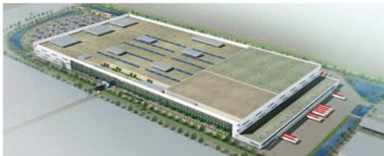
HAMBURG Logistikzentrum H&M Logistik
